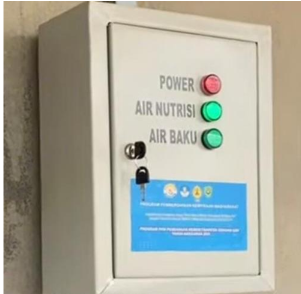
Gambar 5. Alat teknologi tepat guna sistem irigasi tetes berbasis IoT
